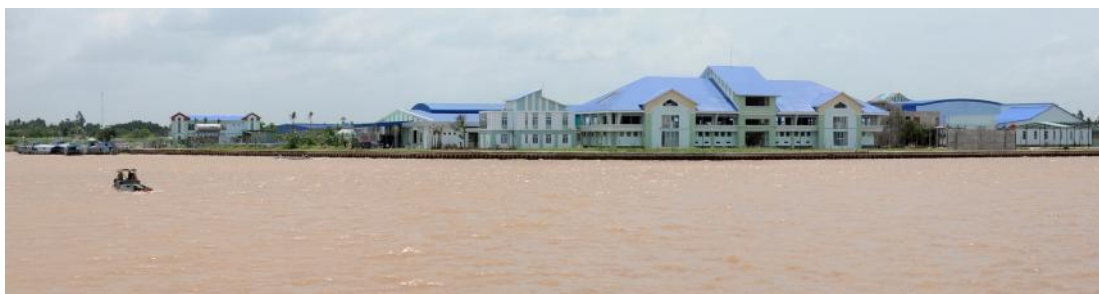
NHÀ MÁY TH Y S N VÀ CÁC CÔNG TRÌNH PH C A IDI NHÌN T SÔNG (IDI FISHERIES FACTORY AND ANCILLARY BUILDINGS, SEEN FROM THE RIVER )
