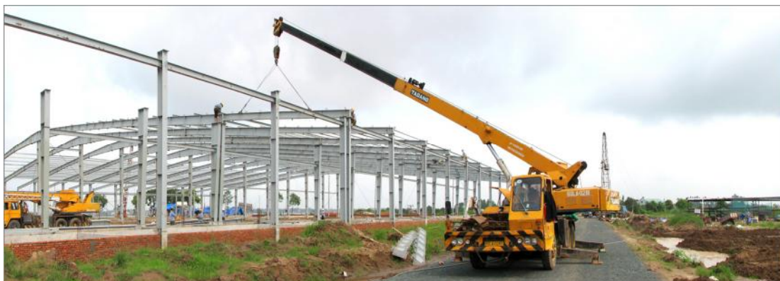
THI CÔNG CÁC NHÀ MÁY THỦY SẢN TRONG KHU CÔNG NGHIỆP VÀM CÔNG, HUYỆN LẤP VÒ, TỈNH ĐỒNG THÁP (CONSTRUCTING FISHERIES FACTORIES IN VAM CONG INDUSTRIAL PARK, LAP VO DISTRICT, DONG THAP PROVINCE)
